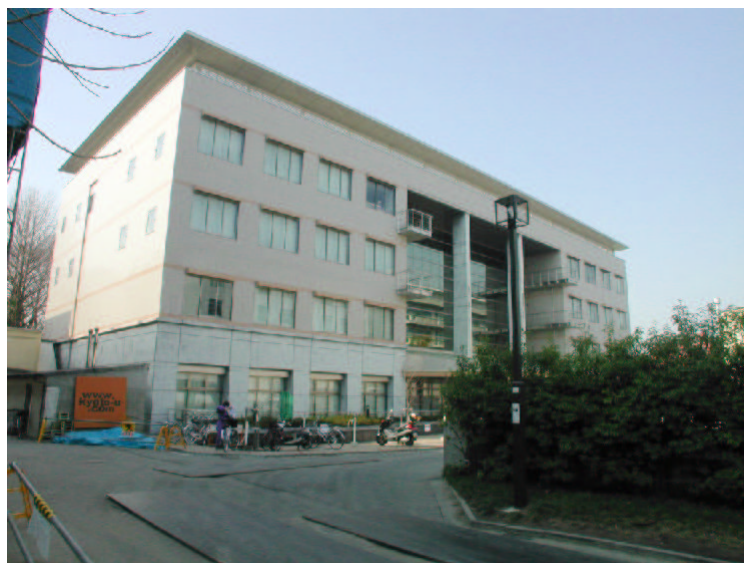
図 1: 総合情報メディアセンター新棟の外観
