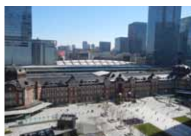
ラウンジから見た東京駅 赤レンガの駅舎や丸の内駅前広場がよく見えます。
