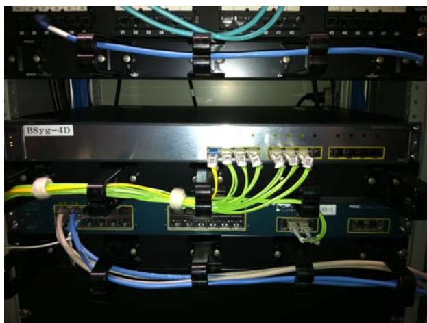
桂キャンパス A4 棟の館内スイッチ (左) と末端スイッチ (右)
