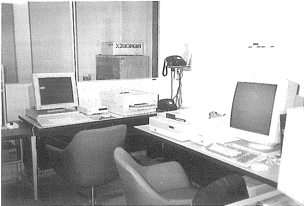
犬山地区に設置されている IP ルータ（写真右側）とメール用ワークステーション（同左側）
