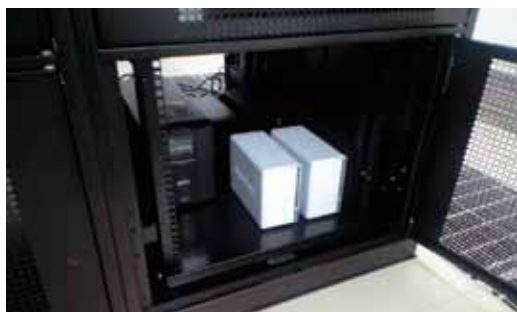
小規模ハウジングサービス (オープンラックに設置したNAS)
